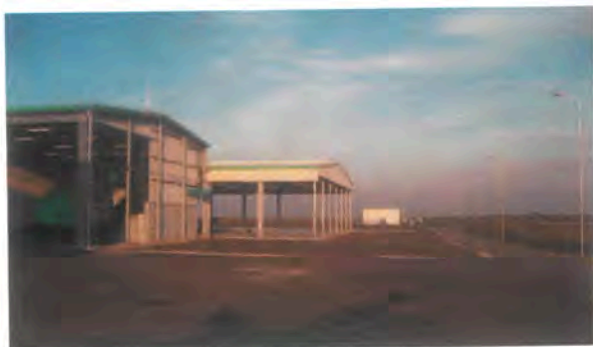
Stația de măcinare și compostare intensivă
