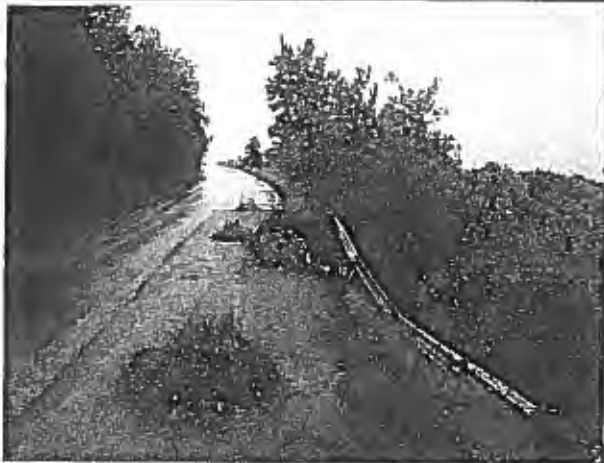
Aspecte foto DJ 679E
