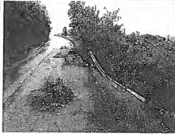
Aspecte foto DJ 679E
