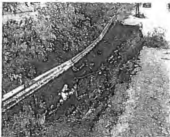
Aspecte foto DJ 679E
