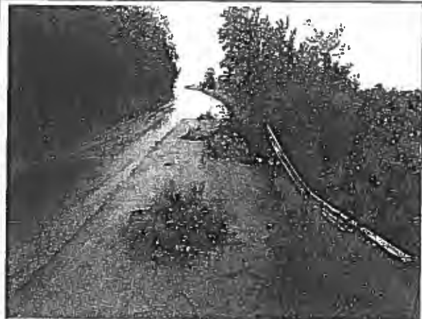
Aspecte foto DJ 679E
