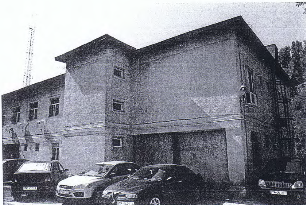
Fatada principala – soclu si trotuar degradat
