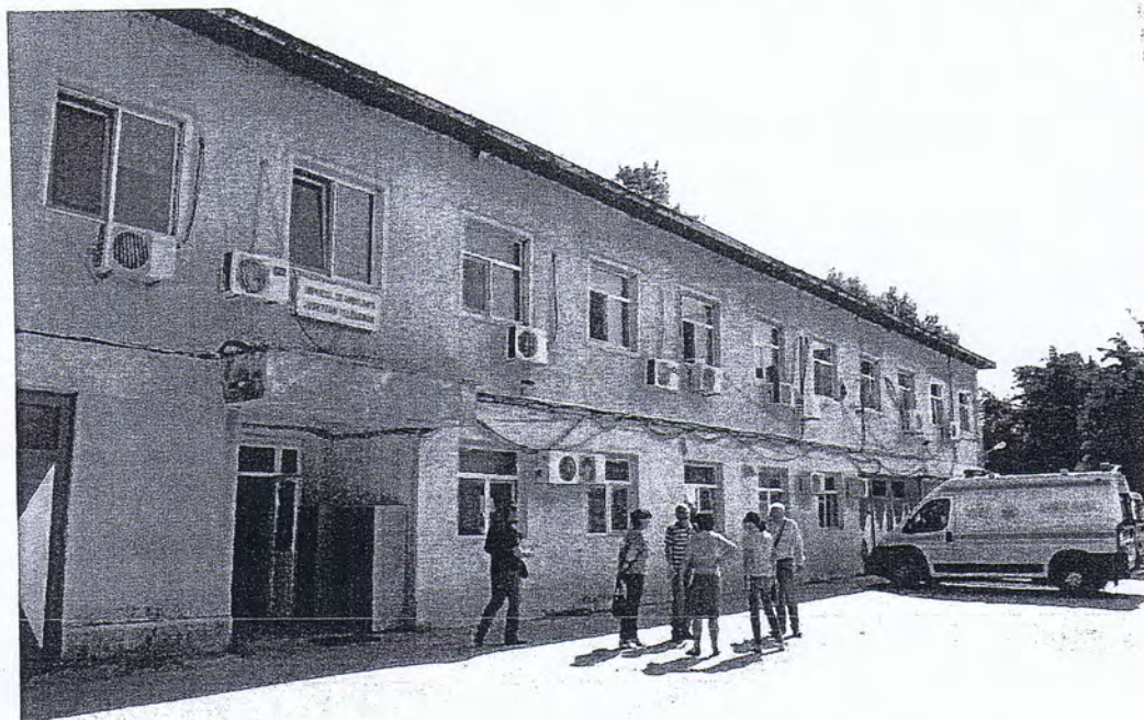
Fatada principala – Urme de degradare ale finisajelor fatadei
