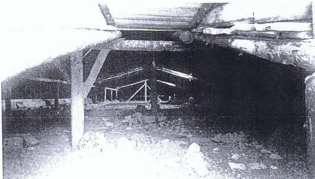
Imagine Pod – Necesita termoizolare si igienizare.
